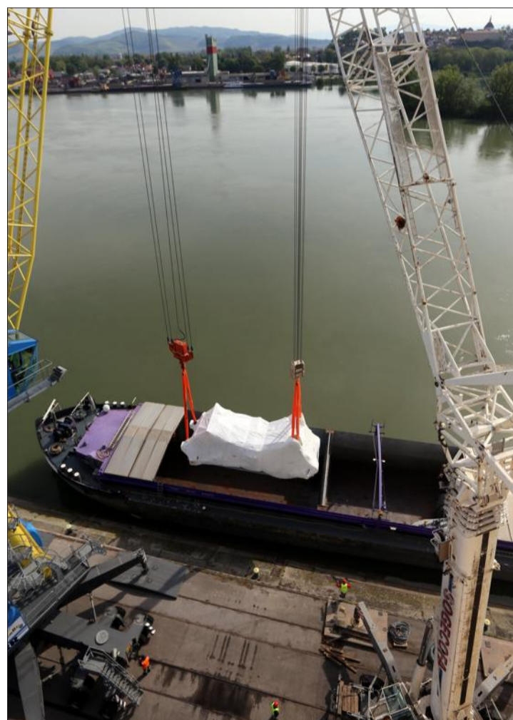
Levé simultanément par deux grues, le chargement de cette pièce de plus de 100 tonnes nécessite une coordination sans faille.
