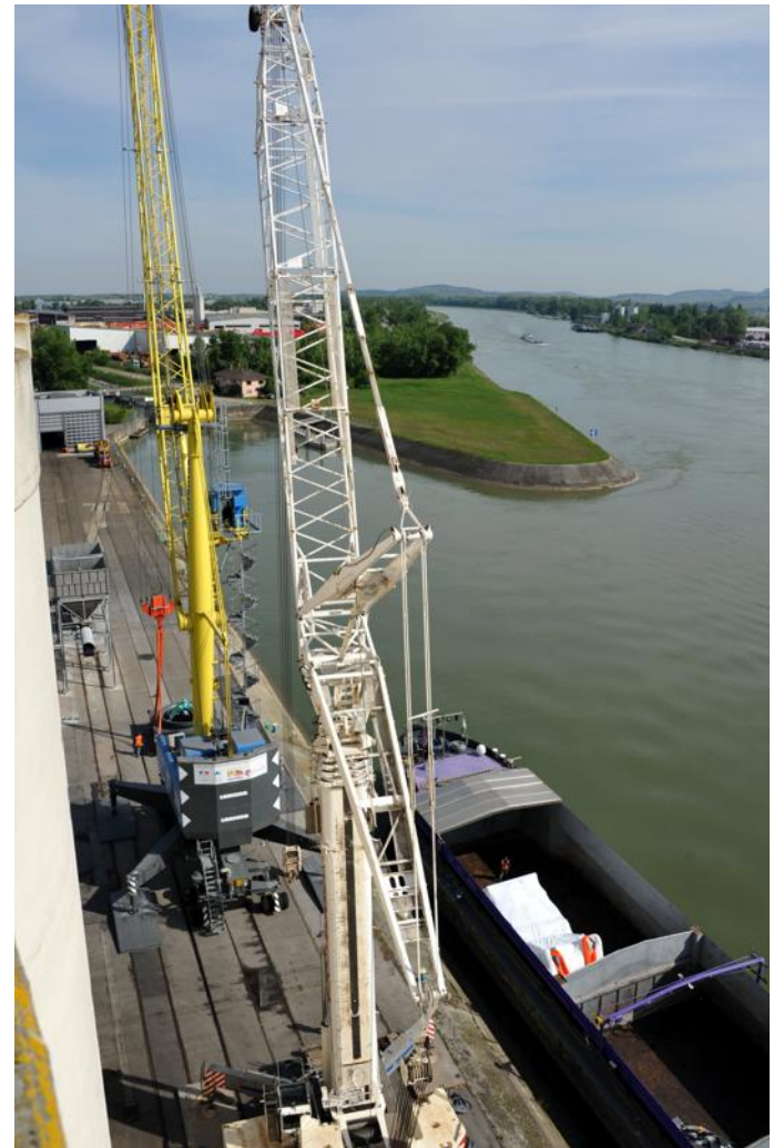
Opération délicate de levage par les deux grues pour le chargement de la tourelle de la grosse pelle minière dans la péniche. PHOTOS DNA - LAURENT HABERSETZER
