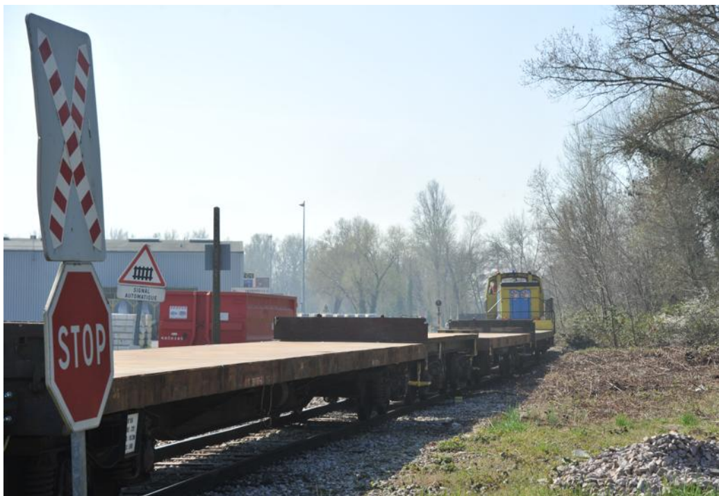
La voie de chemin de fer privée permet de relier Volgelsheim à Marckolsheim.
